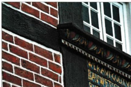
Abb. 49: Schönes Detail eines Fachwerkhause, das der Wasserableitung dient.
