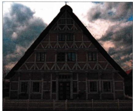
Abb. 1: Norddeutsches Fachwerkhaus von 1618 im Alten Land an der Elbe; Ausfachungen aus Ziegelsteinen; auskragende Geschosse schützen die unterliegenden.
