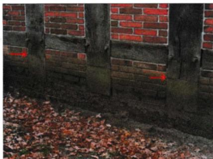
Abb. 38: Negativbeispiel: Schwellenbereich mit Moderfäulepilz-Befall; erkennbar ist, dass die Schwelle schon einmal ersetzt wurde; die Schnittstellen sind sichtbar (†); Spritzwasserzone am Schmutz gut erkennbar.
