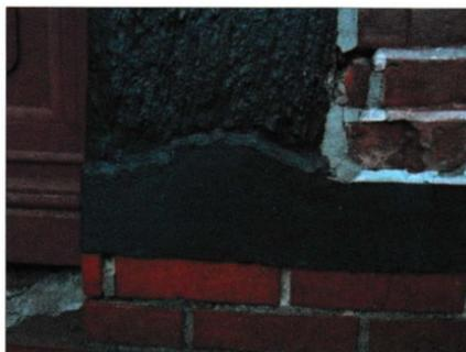
Abb. 3: Verlust der Schwelle aufgrund von Fäuleschäden und Ersatz aus Beton.
