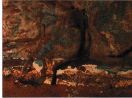
Abb. 13: Derber Strang des Braunen Kellerschwammes durchwächst das Mauerwerk hinter einem Küchenschrank; feinere Mycelien wachsen in alle Richtungen aus.
