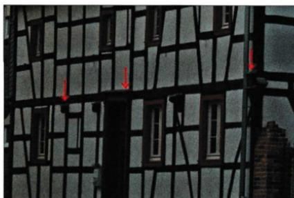
Abb. 50: Kleine Details am Fachwerk, die der Wasserableitung dienen (Pfeile).
