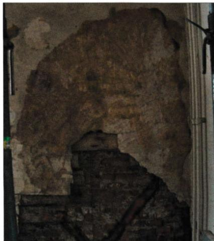
Abb. 20: Detail von Abb. 19 (Innenansicht): Innendämmung entfernt; Mycel mit Zuwachszone und Braunfäuleschaden sind sichtbar.
