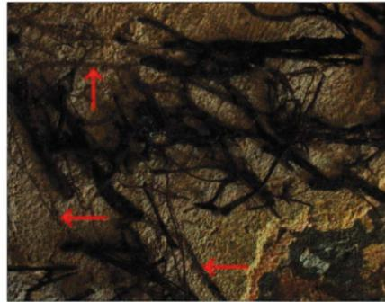
Abb. 15: Brauner Kellerschwamm: Stränge am Putz; auf dem sandigen Grund lösen sich die braun-schwarzen Stränge leicht ab; an den Stellen, an denen sie gewachsen sind, verbleiben braune Ausscheidungs-Spuren (↑).
