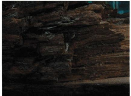
Abb. 24: Echter Hausschwamm: Riegel mit einer massiven Braunfäule, durchzogen von Mycelien und feinen weiß-grauen Strängen, nach dem Ausbau.
