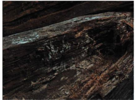
Abb. 48: Doppelbefall: Weißfäuleschaden mit weißem Mycel an einem Zapfenloch durch einen Stachelsporling (*Trechispora* spp.) sowie feiner Würfelbruch, verursacht durch den Braunen Kellerschwamm (*Coniophora puteana*).
