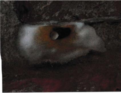
Abb. 27: Echter Hausschwamm: Fruchtkörperbildung an einem Packer; Mycel wächst durch das Rohr des Packers.
