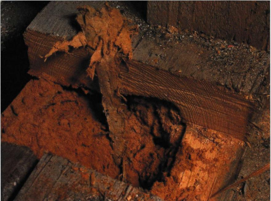
Abb. 18: Stränge und lappiges, braungraues Mycel des Echten Hausschwammes im Inneren eines Mauerbalkens (Innenfäule). Der Balken war dreiseitig ohne erkennbaren Schaden, luftumspült und klang nicht hohl. Das Innere zeigt eine massive Innenfäule (Braunfäule); Begleitschaden durch den Balkenkopf-Pochkäfer / Schwammholzkäfer (*Trypopytus carpini*); trotz des massiven Myceleinwuchses wurde der luftumspülte Holzmantel nicht abgebaut.
