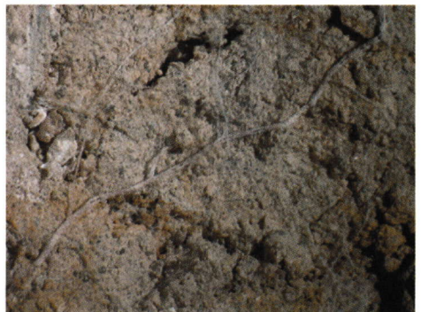
Abb. 31. Brauner Kellerschwamm, untypisch helle Stränge (nicht sklerotisiert); Stränge bis 1 mm im Durchmesser
