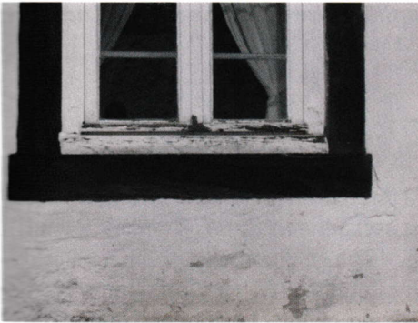
Abb. 41. Hintere Giebelseite, linke Seite, Sprossenfenster: Der vorgesetzte untere Wetterschenkel ist unzureichend mit der hinteren Konstruktion verbunden.
