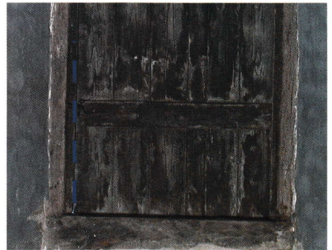
Abb. 29. Giebelseite, Tür innen: Anders als bei der Tür auf der rechten Seite (Abb. 28) sind hier Seitenleisten (--) vorhanden. Es dringt weniger Wasser (Regen und Schnee) ein.
