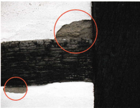
Abb. 18. Giebelseite, der Putz am Übergang von Fachwerk und Ausfachung ist abgeplatzt (O).
