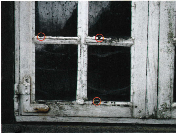
Abb. 32. Fenster: Die Lackschicht und die Verkittungen zeigen Spuren des Alters (O).
