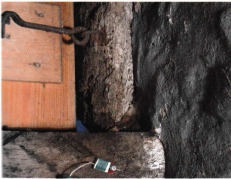
Abb. 28. Schadenssituation innen: Durch fehlende Seitenleisten geht dem Gebäude viel Wärme verloren (vgl. auch Abb. 29).
