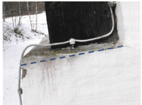
Abb. 7. Vordere Giebelseite, Schwellen und Eckständer aus Eichenholz: Die neuen Teilhölzer (Schuhe) sind zu klein bzw. aus Altholz mit breitem Splintholzanteil (O); Risse weisen nach oben (↑).
