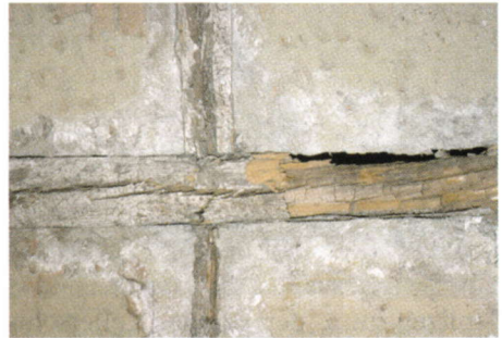
Abb. 23. Echter Hausschwamm: Oberflächenmycel an einem innenliegenden Fachwerk (Putz entfernt); Braunftäule mit Würfelbruch
