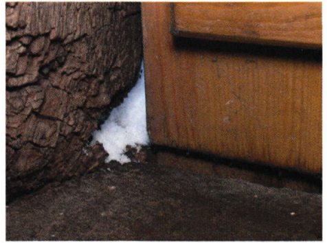
Abb. 27. Vordere Giebelseite, linke Tür von innen aus gesehen: Eintrittsöffnung auch für Flugschnee.
