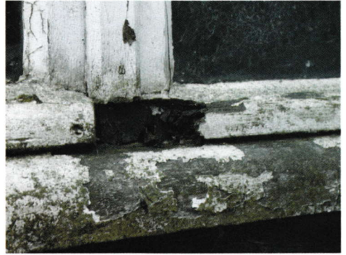
Abb. 34. Detail des massiven Schadens durch einen Braunfäuleerreger
