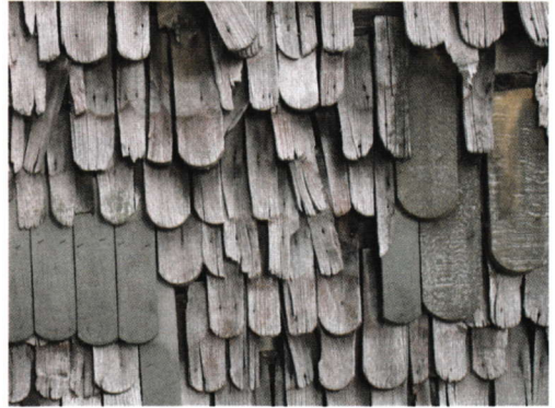
Abb. 21. Detail: drei unterschiedliche Schindelformen wurden verarbeitet. Nägel sollten nicht im Bereich des Wasserablaufes eingeschlagen werden (GRIEP 2002).
