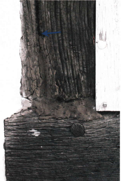
Abb. 38. Oberhalb der Verspachtelung liegt ein Riss (↑), eingedrungenes Wasser kann schlecht ablaufen oder verdunsten.
