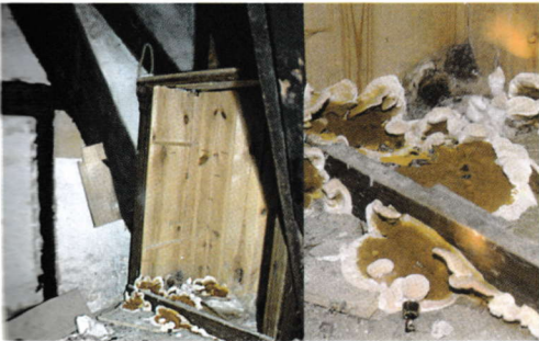
Abb. 22. Echter Hausschwamm: brauner, weißbrandiger und dicker Fruchtkörper; Schälens am Fachwerk nicht sichtbar.
