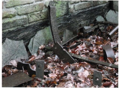
Abb. 3. Ansicht von hinten: Schwellen verschwinden hinter Blättern und Zweigen; die Abdeckung ist zerbrochen.
