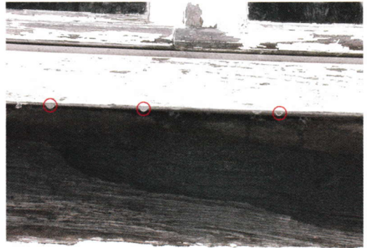
Abb. 41. Hintere Giebelseite, linke Seite, Sprossenfenster: Der vorgesetzte untere Wetterschenkel ist unzureichend mit der hinteren Konstruktion verbunden.
