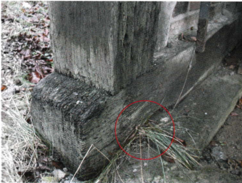
Abb. 2. Offener Anbau, hintere Schwelle, von der Seite aufgenommen: Schwelle liegt in einem erdähnlichen Bereich (O).
