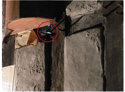
Abb. 13. Vordere Giebelseite, Dachgeschoss: Eintrittsöffnung (O) für Flugschnee
