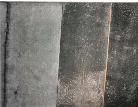
Abb. 51. Decke einer nicht mehr genutzten Räucherkerker mit Schimmelpilzbildung
