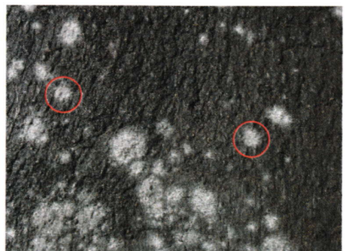
Abb. 52. Detail der verschimmelten Oberfläche mit einzelnen Schimmelpilzkolonien (O)
