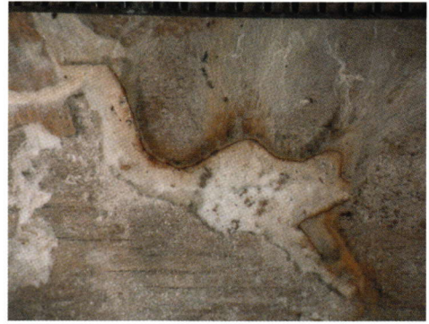
Abb. 11. Ausgebreiteter Hausporling, weißes, styroporartiges Oberflächenmycel; unterliegendes Holz mit Weißfäule
