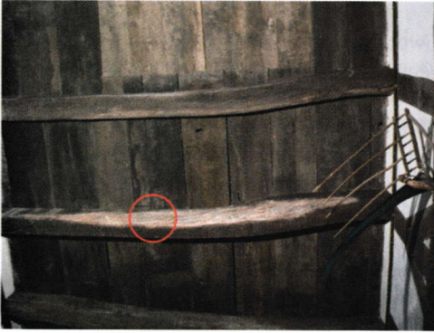
Abb. 47. Schimmelpilzbefall an der Decke einer Diele (O).
