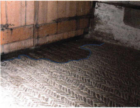
Abb. 26. Innenseite, Diele mit Steinfußboden: Wassereinlauf von über einem Meter in die Diele (Linie)
