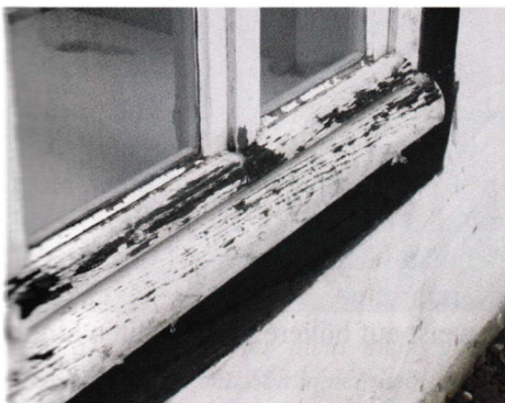
Abb. 43. Sprossenfenster mit Wartungsbedarf der Beschichtung.
