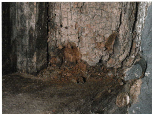
Abb. 25. Detail des Eichenholzes: Schäden durch Insekten ( Xestobium rufovillosum ) und Pilze
