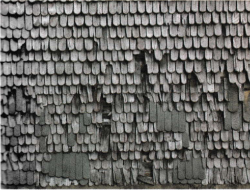
Abb. 20. Ausschnitt einer vergrauten, reparaturbedürftigen Fassade mit Schindelwandverkleidung. Neue Schindeln können meist problemlos eingeschoben werden.
