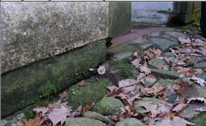
Abb. 18: Schwelle mit extremer Durchfeuchtung, auf der Moose, Algen, Flechten und Pilze wachsen; Die Schwelle hat keinen Spitzschutz; es liegen erdähnliche Bedingungen vor.
