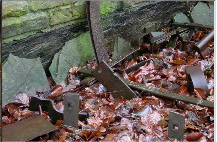
Abb. 15: Schuppen: Schwellen aus Eichenholz verschwinden hinter Blättern und Zweigen; die provisorische Abdeckung aus Schieferplatten ist zerbrochen.
