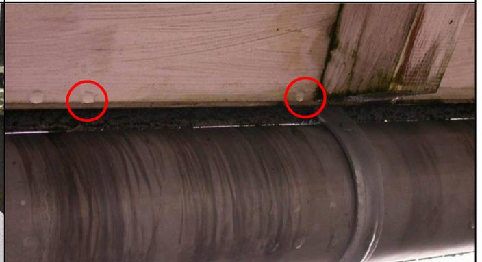
Abb. 41: Der Anschluss der Regenrinne passt nicht, die Fassade und die Dachunterseite werden durchnässt (Kreise).
