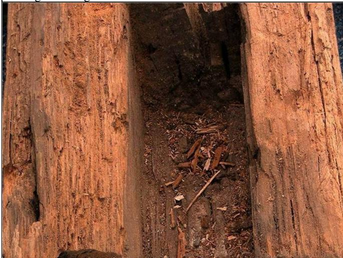
Abb. 10: Aufgespaltenes Bauteil; Braunfäule verursacht durch Weißen Porenschwamm/Braunfäuletramete (*Antrodia* sp.) im Verbindungsbereich.
