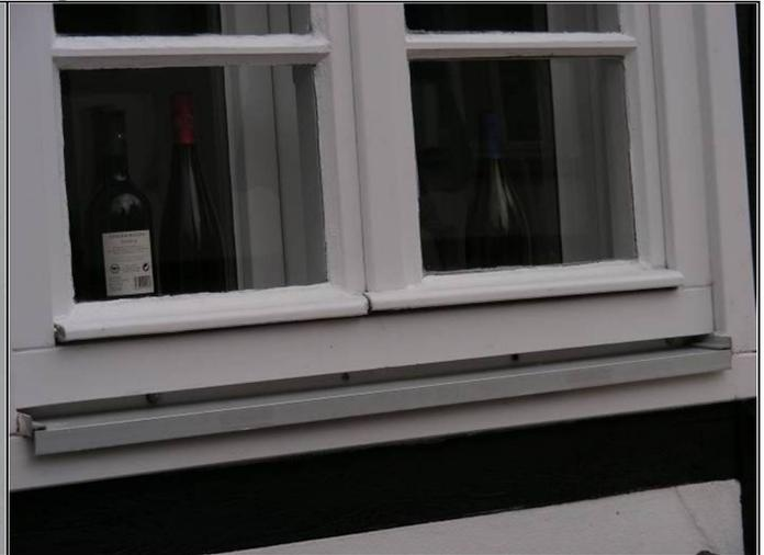
Abb. 79: Baulicher Holzschutz: Wetterschutzschiene am Fenster mit Endkappen. Die Endkappen müssen am Blendrahmen angedichtet werden, zudem ist die Verbindung zwischen Endkappe und der Wetterschutzschiene wasserdicht zu verkleben.
