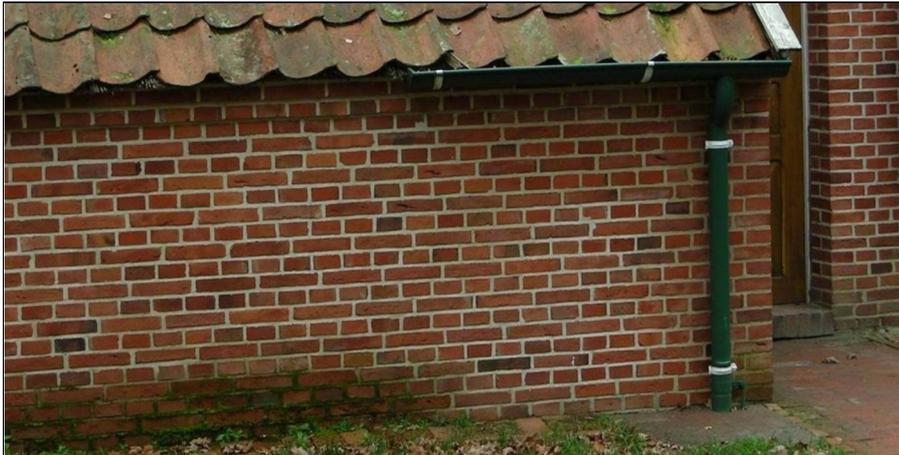
Abb. 4: Verminderung von Spritzwasser bei kleinem Dachüberstand: Das Bild zeigt die Wirkung einer Dachrinne auf den Gebäudefuß bei normaler Regen-Belastung: rechts mit Rinne – der Gebäudefuß ist meist trocken –, links ohne Rinne – der Gebäudefuß ist meist feucht und zahlreiche Moose und Algen siedeln sich als Indikatoren der hohen Feuchtwerte an.
