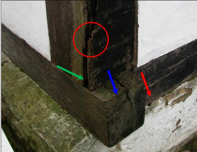
Abb. 27: Bewitterte Giebelseite, Schwelle und Eckständer aus Eichenholz: Durch überstehende Ränder und Risse (Kreis) dringt Wasser ein; Risse in Schwellen weisen nach oben (blauer Pfeil); Wasser kann einlaufen; weitere Wassereintrittsporten (roter Pfeil). Die Unebenheit der Schwelle und der Jahringverlauf drücken den Rand des neu angesetzten Eckstiels nach außen (grüner Pfeil).
