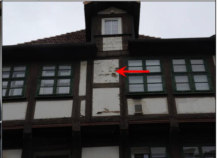
Abb. 47: Grenzen der Wirkung eines Dachüberstandes: der untere Dachüberstand ist unterbrochen, unterhalb sind vermehrt Putzschäden erkennbar (Pfeil).
