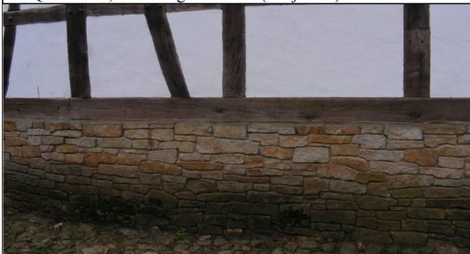
Abb. 31: Schwelle mit ausreichendem Spitzwasserschutz.
