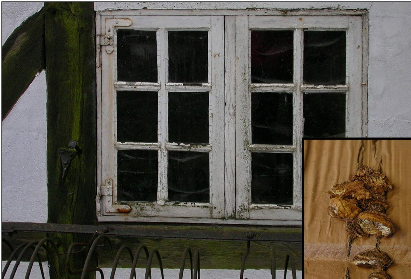
Abb. 70: Das Blendrahmen-Fenster liegt bündig in der Fassade, ohne baulichen Holzschutz ist es stark der Witterung ausgesetzt: Die Beschichtung und die Verkittungen zeigen Spuren des Alters; Eckbild: Fruchtkörper eines Zaunblättlings (*Gloeophyllum sepiarium*).
