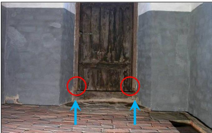
Abb. 64: Übersicht einer Stall-Tür; Schadensschwerpunkte (Kreise) sind immer Schwellen-Bereiche und die anschließenden Zargenteile; feuchte Stellen (Pfeile).
