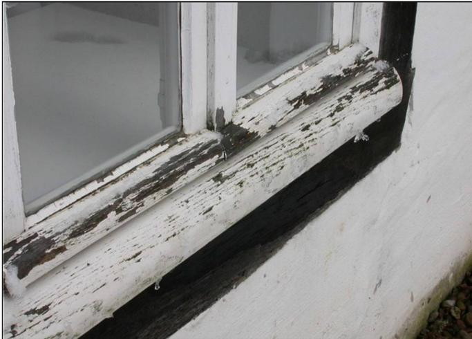
Abb. 88: Sprossenfenster mit Wartungsbedarf der Beschichtung.
