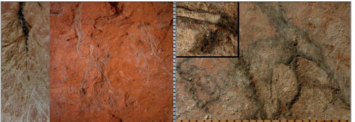
Abb. 68: Untypisch helle, weil junge Stränge des Braunen Kellerschwamms am Ziegelstein (nicht sklerotisiert – jung eingetrocknet, daher so hell); Strangdurchmesser unter 1 mm; Maßstab mit Millimeteinteilung (rechts); linkes Bild: Sklerotierungsprozess
