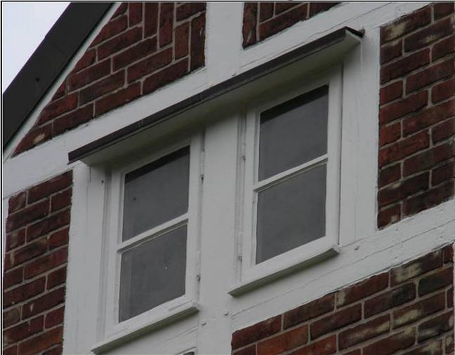
Abb. 78: Baulicher Holzschutz: Historisches Fachwerk-Denkmal ohne Dachüberstand: Die Fenster liegen bündig in der Fassade und wurden mit einem kleinen, metallverkleideten Vordach aus Holz geschützt.
