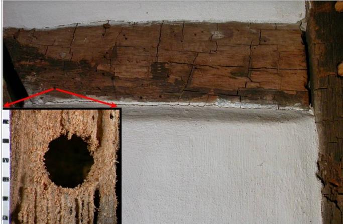
Abb. 54: Innenansicht eines Fachwerkriegels mit grobem Würfelbruch, verursacht durch Braunen Kellerschwamm (*C. puteana*); Ausflughöcher: Bunter Nagekäfer (Eckbild mit Details des Loches).
