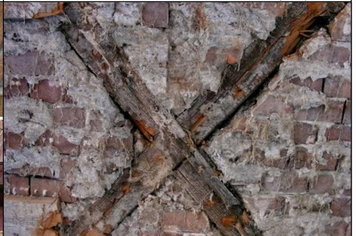
Abb. 39: Echter Hausschwamm (*Serpula lacrymans*) als Folge einer ungünstigen Innendämmung, mit massivem Braunfäule-Schaden; Dämmung entfernt. Feuchteintrag entstand durch Kondensation von feuchter Innenluft.
