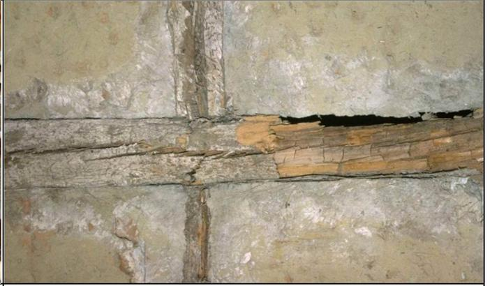
Abb. 61: Echter Hausschwamm: Oberflächenmycel an einem innen liegenden Fachwerk (Putz entfernt) nach Wasserschaden; intensive Braunfäule mit Würfelbruch; das Mycel hat den Lehm – im Gegensatz zum Holz – nicht vollständig bewachsen.
