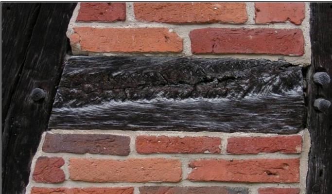
Abb. 62: Historischer Fachwerk-Riegel mit Anomalie in der Holzstruktur (Wechseldrehwuchs).
