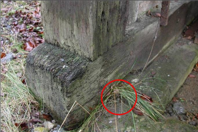
Abb. 14: Offener Anbau, Schwelle aus Eichenholz, von der Seite aufgenommen: Die Schwelle liegt in einem erdähnlichen Bereich (Kreis) und ist stark spritzwassergefährdet.
