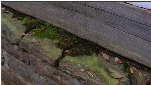
Abb. 3: Verschmutzter und mit Moos bewachsener Sockel; das Moos hält besonderes gut die Feuchtigkeit und befeuchtet das Holz; mit einer regelmäßigen Reinigung kann dem begegnet werden.
