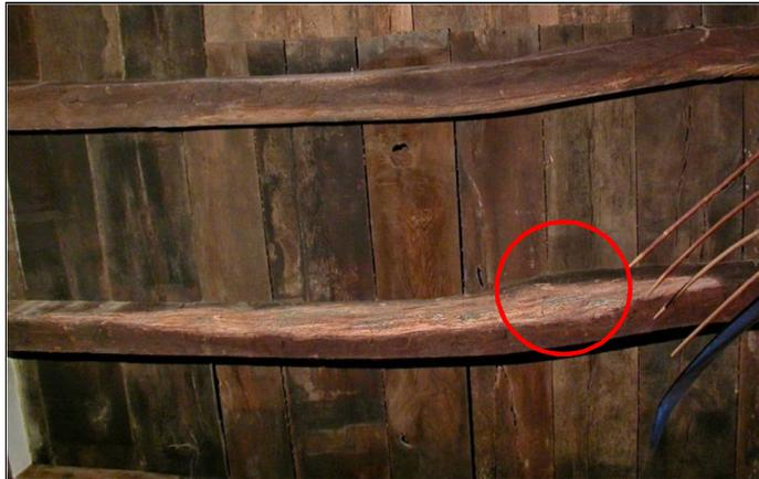
Abb. 92: Grünlicher Schimmelpilzbefall an einem oberflächlich faulen Deckenbalken im Innenraum einer Diele (Kreis).
