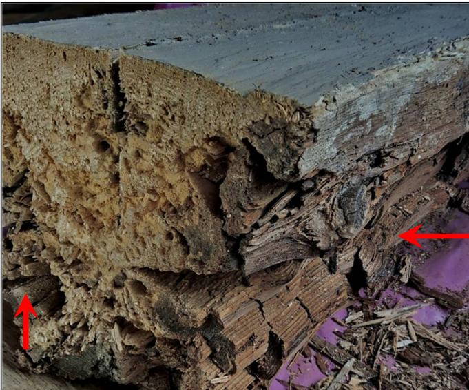
Abb. 44: Folgen einer ungünstigen Innendämmung: typisches Schadbild: äußerer Teil intakt (oben grau beschichtet) und massiver Braunfäule-Schaden innen und im seitlichen Teil (unten und rechts; ↑); mit Insektenschaden (Bunter Nagekäfer – *Xestobium rufovillosum*).
