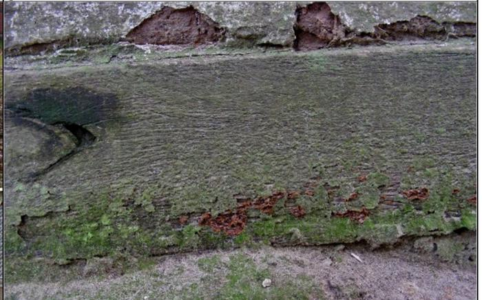
Abb. 17: Detail von Abb. 16: Schwelle, im unteren Bereich mit Befall durch einen seltenen Eichenholz-Spezialist: Umberbrauner Borstscheibling (*Hymenochaete rubiginosa* – Weißfäule-Erreger).
