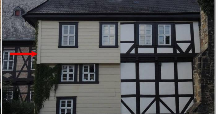
Abb. 37: Teil-Abdeckung einer Fassaden-Hälfte mit beschichteten Brettern auf zwei Seiten um eine stark bewitterte Ecke (Pfeil).
