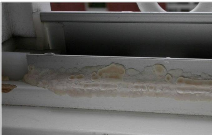
Abb. 80: Striegelige Tramete (*Trametes hirsuta*) an einem Fenster mit Wetterschutzschiene, deren Verbindung zur Endkappe nicht wasserdicht verklebt war.
