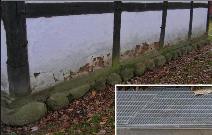
Abb. 16: Schwelle, von der Seite aufgenommen: Die Schwelle liegt zwar etwas erhöht, aber immer noch im Spritzwasserbereich, der grüne Algenbelag an den Ständern zeigt die Spritzhöhe; Eckbild: Gitter einer Drainage als mögliche Verbesserung.
