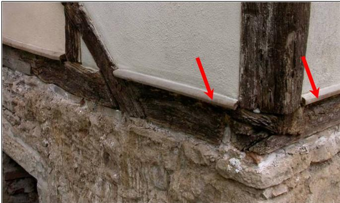
Abb. 22: Schwelle und Eckständer aus Eichenholz: Durch feine Leisten (Pfeile) wird versucht, am Gebäude ablaufendes Wasser abzuleiten, aber nicht alle Teile wurden erfasst.
