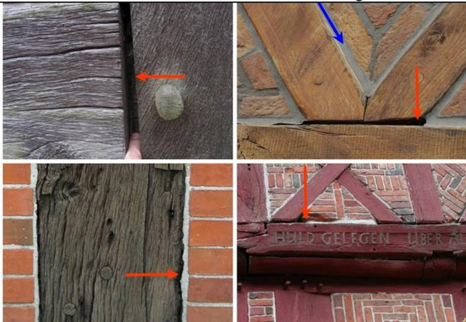
Abb. 38: Offene Fugen zwischen Gefach und Balken bzw. Hölzern (roter Pfeil); Mauerwerk und Holz dehnen sich bei Wasseraufnahme und Temperatur-Veränderungen unterschiedlich aus, so dass Risse im Holz und offene Fugen entstehen; Wasserablauf (blauer Pfeil).
