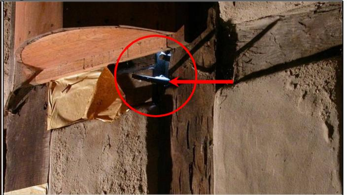
Abb. 35: Bewitterte Giebelseite, Dachgeschoss: Eintrittsöffnung (Kreis) für Flugschnee (↑)
