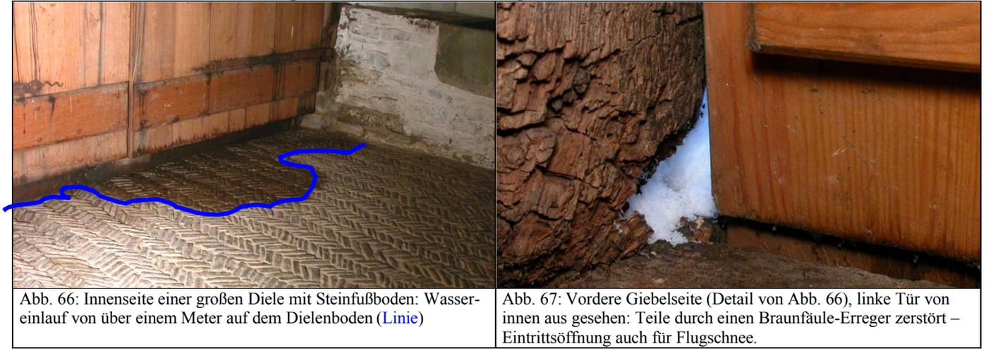
Abb. 66: Innenseite einer großen Diele mit Steinfußboden: Wasser-einlauf von über einem Meter auf dem Dielenboden (Linie)
