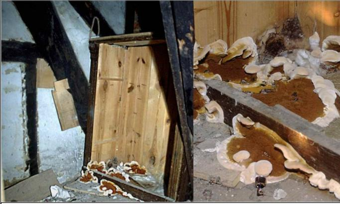
Abb. 60: Echter Hausschwamm (*Serpula lacrymans*): braune, weißrandige und dicke Fruchtkörper; Schäden waren am Fachwerk von außen nicht sichtbar; nicht sichtbare Teile mit massiven Braunfäule-Schäden.
