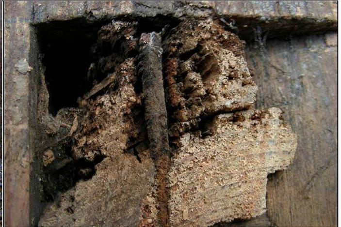
Abb. 9: Detail von Abb. 8: Der Zapfen ist deutlich auf einer Seite braunfäul mit einem muschelähnlichen Bruchbild, der Nagel ist verrostet und gebrochen.
