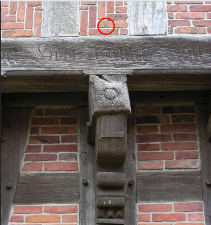
Abb. 56: Baulicher Holzschutz durch ausragende Geschosse; oben ist der Witterungs-Schutz geringer, da der Dachüberstand kleiner ist.
