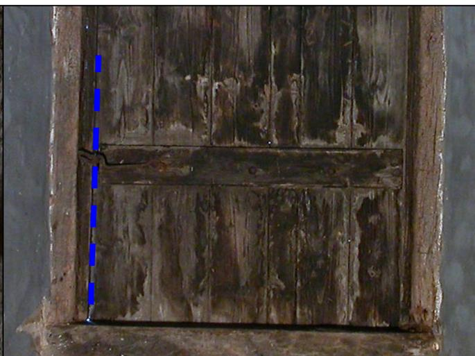
Abb. 72: Wetterseite eines Fachwerkhäuses von innen: Anders als bei der Tür (Abb. 71) sind hier Deckleisten (**Linie**) vorhanden. Es dringt weniger Niederschlag (Regen und Schnee) ein.
