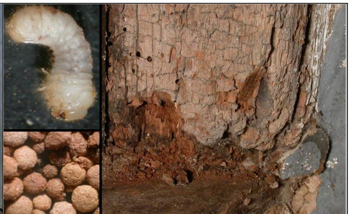
Abb. 65: Detail des Eichenholzes von Abb. 64: Schäden durch Pilze (Braunfäule-Schaden) und Insekten (Bunter Nagekäfer, *Xestobium rufovillosum*); Eckbild zeigt diskusförmiges Bohrmehl und Larve.
