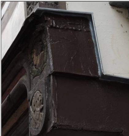
Abb. 24: Nicht unterlüftete Blechabdeckung zweier Balken (Nutzen wegen der fehlenden Unterlüftung unklar).
