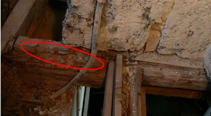
Abb. 36: Braunfäule (Oval) durch einen Weißen Porenschwamm / Braunfäuletrameete unter einem Bad ohne Abdichtungsebene.
