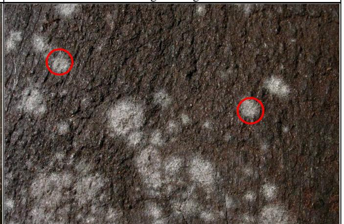
Abb. 97: Detail der verschimmelten Oberfläche von Abb. 96 mit einzelnen Schimmelpilzkolonien z. B. von *Aspergillus* sp. (Kreise)
