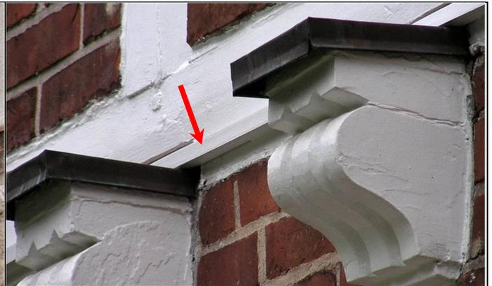
Abb. 23: Balkenköpfe mit Abdeckungen aus Kupfer und eine unauffällige weiße Abdeckleiste am unteren Teil des Schwellbalkens (Pfeil), die Wasser vom Ziegelstein-Gefache fernhalten soll.
