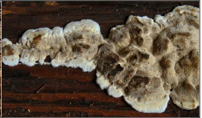
Abb. 43: Ausgebreiteter Hausporling (*Donkioporia expansa*): großer Fruchtkörper an einem Ständer.
