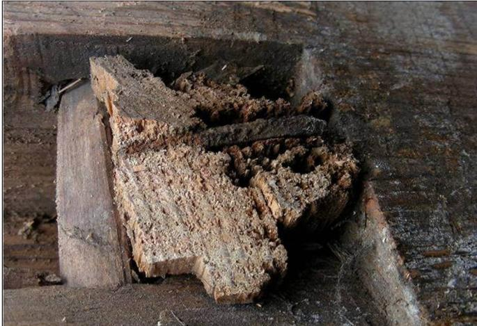
Abb. 8: Aufgesägtes Bauteil; Zapfen wurde durch eine Braunfäuletramete (*Antrodia* sp.) geschädigt (feines weißes Mycel rechts), eine Drainage-Bohrung zum Wasserabfluss war nicht vorhanden.
