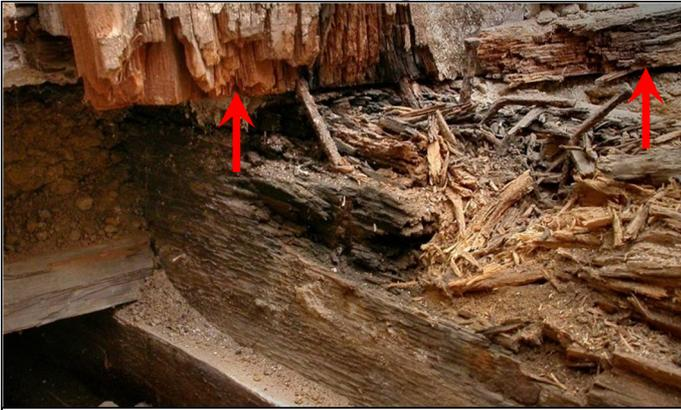
Abb. 42: Ausgebreiteter Hausporling (*Donkioporia expansa*): Weißfäule-Erreger, zudem Braunfäuleschaden (Pfeile) durch Braunfäuletramete.
