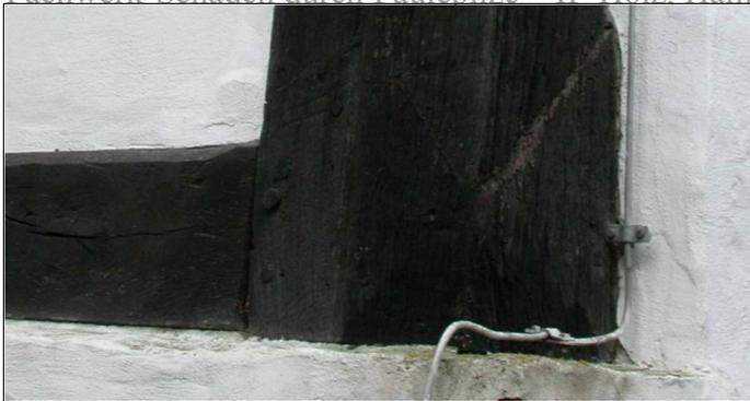
Abb. 25: Übersicht: Giebelseite, Eckständer aus Eichenholz mit fehlender Abschrägung; vergleiche z. B. vorgeschlagene Abschrägung in Abb. 26.
