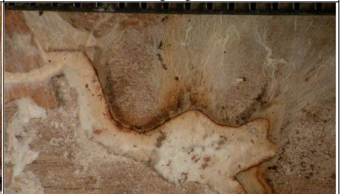
Abb. 30: Ausgebreiteter Hausporling, weißes, styroporartiges Oberflächenmycel; unterliegendes Holz mit deutlicher Weißfäule (Holzfaserig); Maßstab mit Millimetern (oben)
