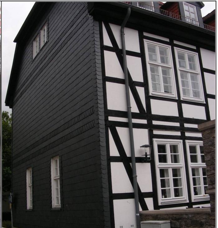
Abb. 57: Fassade wurde mit einer Wandverkleidung auf der stark bewitterten Seite einer Durchfahrt geschützt; Garten- und Straßenseite mit Fachwerkansicht.
