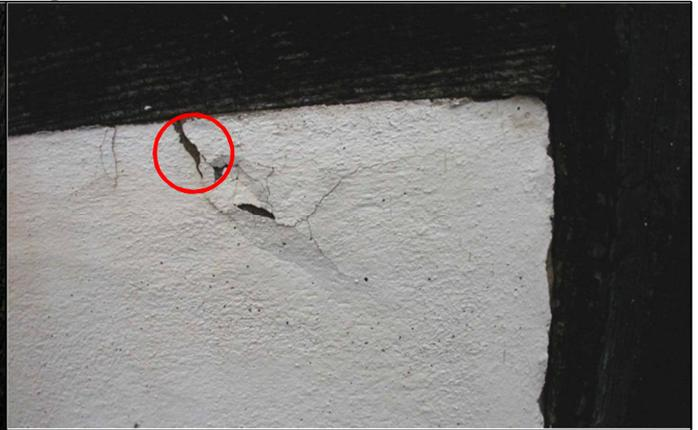
Abb. 53: Weiteres Detail: Risse in der Ausfachung (Kreis), mehr Wasser dringt ein – das Quellen und Schwinden verstärkt sich.
