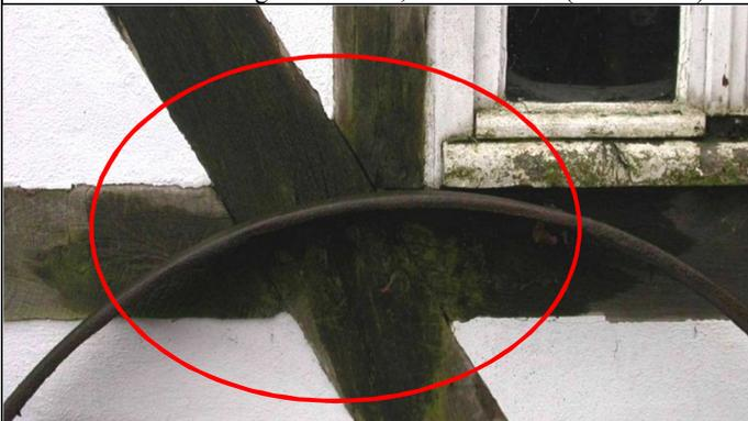
Abb. 40: Fachwerkwand einer Schmiede mit angelehntem Metallring: An diesem Bild wird die Wirkung von Spitzwasser deutlich (Oval).
