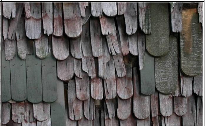
Abb. 59: Detail: drei unterschiedliche Schindelformen wurden verarbeitet. Nägel sollten nicht im Bereich des Wasserablaufes eingeschlagen werden (GRIEP, 2002).
