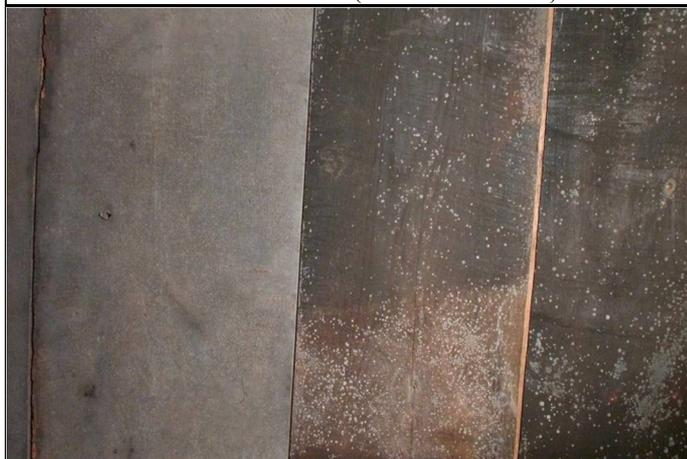
Abb. 96: Decke einer nicht mehr genutzten Räucherammer mit starker Schimmelpilzbildung (graue Flecken bzw. Belag)
