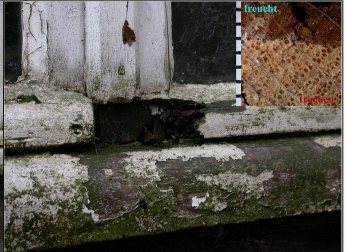
Abb. 74: Detail aus Abb. 73: massiver, tiefgreifender Schaden durch einen Braunfäule-Erreger; Würfelbruch sichtbar; Eckbild: Abhängigkeit des Fäule-Verlaufes von der Holzfeuchte – nicht befallene, untere Eichenkernholz-Bereiche waren zu trocken.
