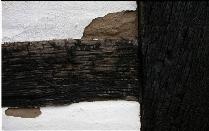
Abb. 52: Giebelseite, der Putz am Übergang von Fachwerk und Ausfachung ist abgeplatzt.
