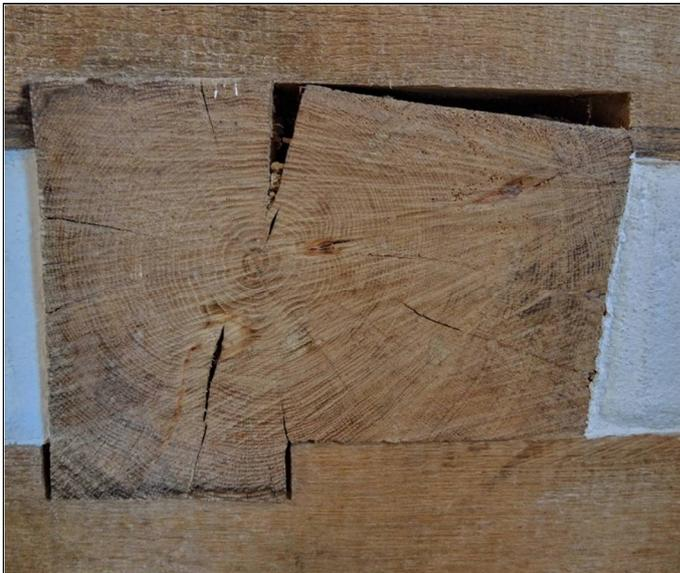
Abb. 48: Verformung und Risse im nass eingebauten und im Gebäude getrockneten Eichenholz (mit Markröhre, also nicht herzfrei); hier ohne Folgen, da im Innenraum.
