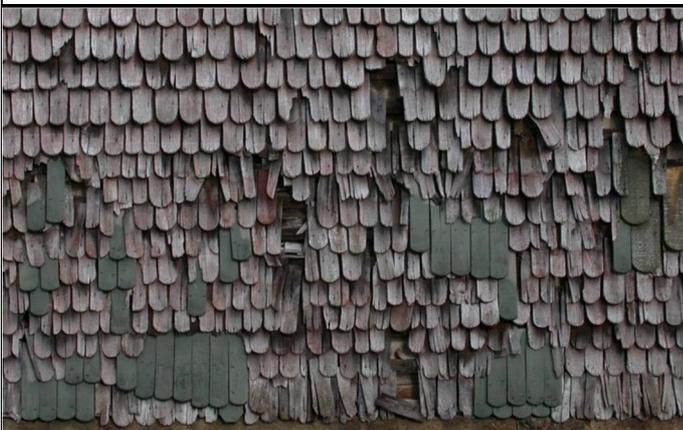
Abb. 58: Ausschnitt einer vergrauten, reparaturbedürftigen Fassade mit Schindel-Wandverkleidung. Neue Schindeln können vom Dachdecker meist problemlos eingesetzt werden.
