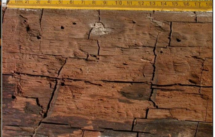
Abb. 55: Detail von Abb. 54: Braunfäule mit grobem Würfelbruch quer zur Holzfaser – bis ca. 9 cm groß; Ausflughöcher: Bunter Nagekäfer (*Xestobium rufovillosum*).
