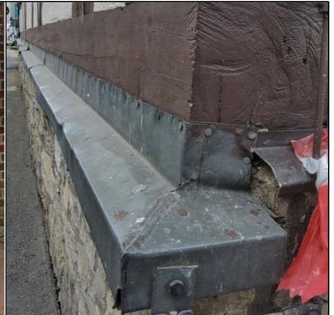
Abb. 5: Verminderung von Spritzwasser: Robuster Spritzwasserschutz an einem stark begangenen Weg. Auf zusätzliche Abdichtung aus Silikon wurde verzichtet.
