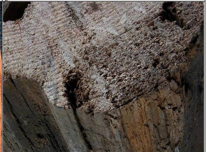
Abb. 11: Braunfäule mit einem muschelähnlichen Bruchbild auf der Unterseite einer Schwelle unterhalb eines Zapfenloches; Verursacher: Braunfäuletramete (*Antrodia* sp.).
