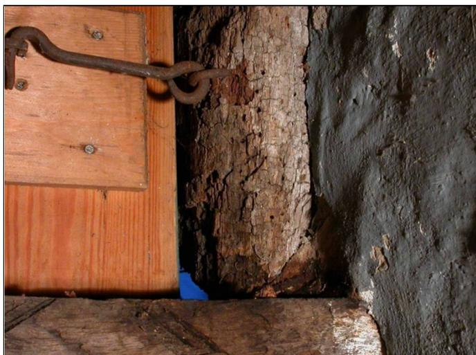
Abb. 71: Wetterseite eines Fachwerkhäuses von innen mit Schadenssituation: Durch fehlende Seitenleisten an der Türzarge geht dem Gebäude Wärme verloren und Wasser dringt ein (vgl. auch Abb. 72).
