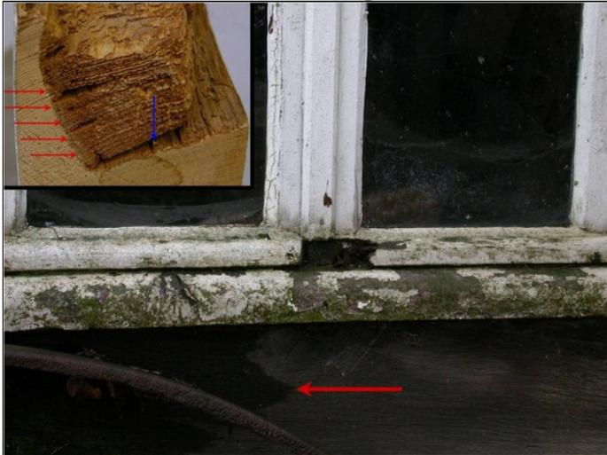
Abb. 73: Fenster mit massiven Schäden an der Holzsubstanz am unteren Wetterschenkel und am Fensterflügel; die Moose und Algen zeigen die Vernachlässigung an; das unterliegende Fachwerk wird feucht (roter Pfeil), Eckbild: Fäulebild im Querschnitt (Pfeile: scharfe Befallsgrenze); Mycel (blauer Pfeil).
