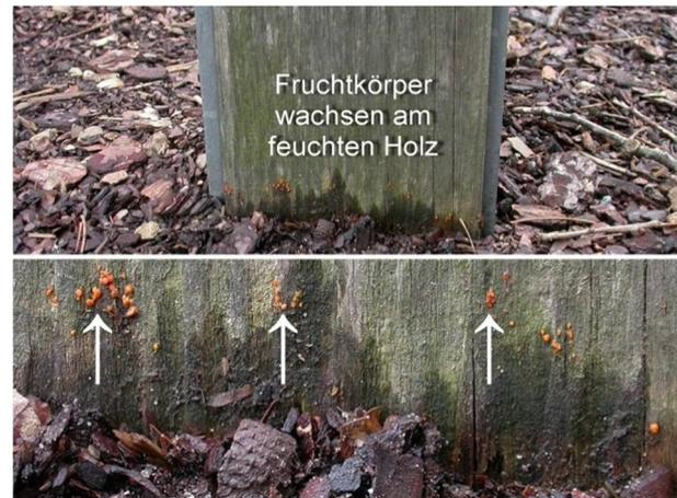
Abb. 4: Nebenfruchtform der Zerfließenden Gallerträne an einem Schaukelpfahl mit Moder- und Braunfäule in der Erd-Luft-Zone: für Kinder nicht einschätzbar.
