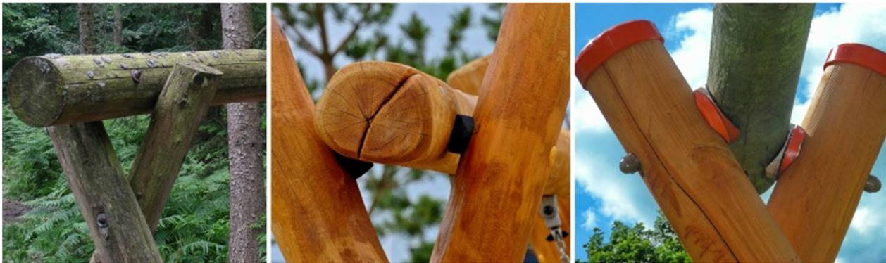
Abb. 17: Schaukeln: links: Die Verbindungsflächen sind durch die geringe Auflage der Rundhölzer klein, Wasser kann gut ablaufen. Trotz des erheblichen Alters sind augenscheinlich keine Schäden erkennbar; Mitte: kleine Verbindungsflächen zwischen Abstandhalter und Holz; rechts: große Abstandhalter; die Wasserabflussmöglichkeit ist unklar.
