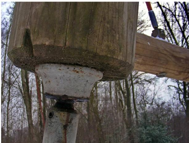
Abb. 20: Trennung von Pfahl und Boden durch flexible Verbindung (ca. 11 Jahre alt) ohne erkennbaren Fäuleschaden.
