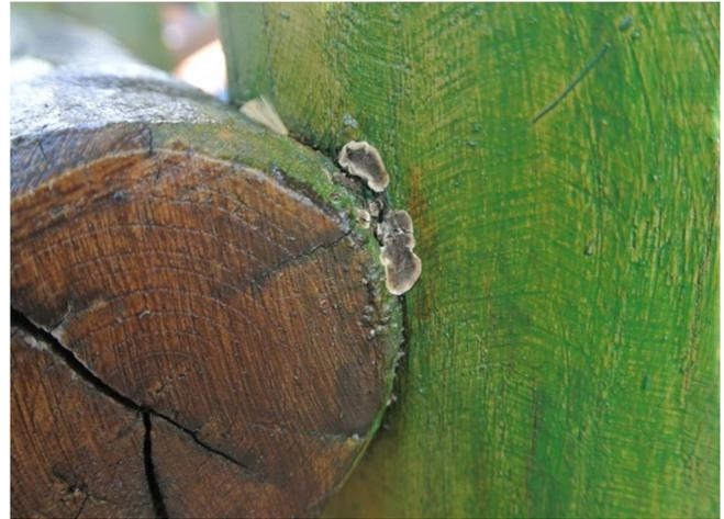
Abb. 1b: An der ausgefrästen Verbindungsfläche zwischen den Rundhölzern ist ein Feuchtenest entstanden. Ein erster Pilz hat sich angesiedelt und Fruchtkörper gebildet – hier ein kleiner Schichtpilz (*Stereum* sp.); die Fäule-Entwicklung schreitet langsam und meist im Splintholz voran.
