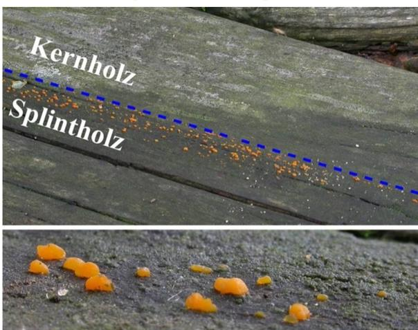
Abb. 5: Gelbe Nebenfruchtform der Zerfließenden Gallerträne an einem Deck: Die Pustel-ähnlichen Fruchtkörper sind nur auf dem Splintholz gewachsen.
