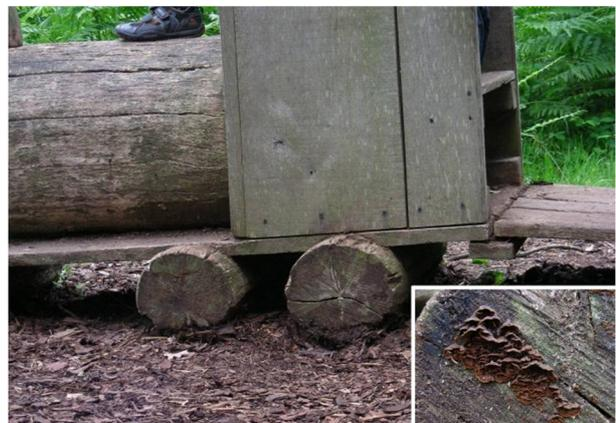
Abb. 9: Massive Eichenlok, die aufgrund eines fortschreitenden Befalls mit Weißfäulepilzen (z. B. *Hymenochaete* sp. im Eckbild) langsam einsinkt.
