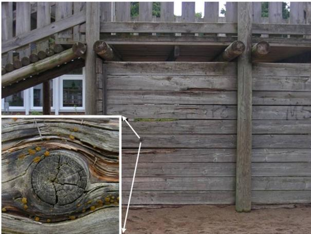
Abb. 3: Kleine Fruchtkörper (Eckbild) der Zerfließenden Gallerträne (*Dacrymyces stillatus*) an einer luftumspülten Spielburg-Wand (ca. 28 Jahre alt) mit Braunfäule; die Fäule-Entwicklung schreitet nur langsam voran.
