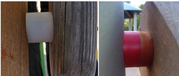
Abb. 18: Einfach können Knotenpunkte z. B. an Geländern aufgelöst werden.
