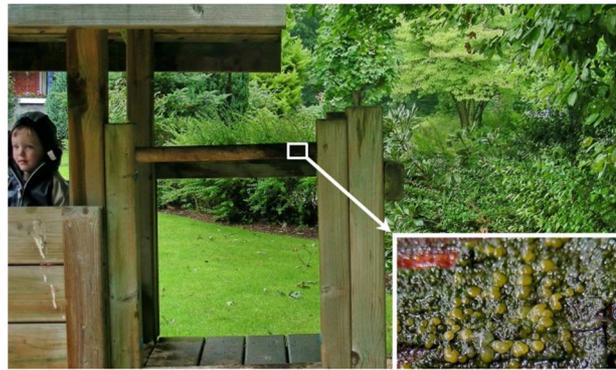
Abb. 11: Ablaufendes Wasser vom Dach führt zu starker Befeuchtung des Handlaufs der Lokomotive und in der Folge zu einem Braunfäule-Schaden durch Gallertränen.
