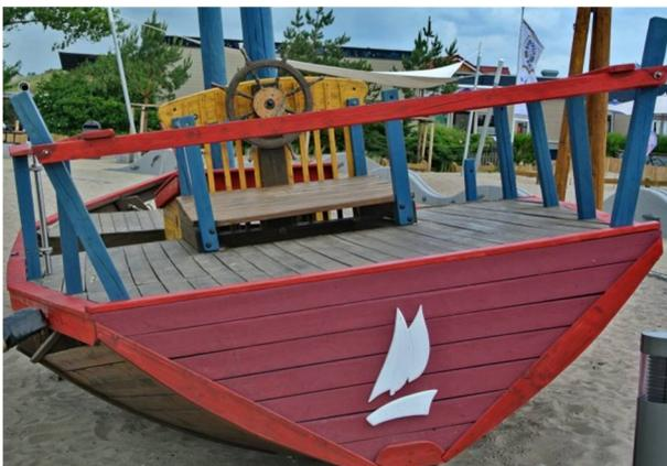
Abb. 8: Durch die Schrägstellung des Decks (5 Jahre alt) laufen Niederschläge gut ab.
