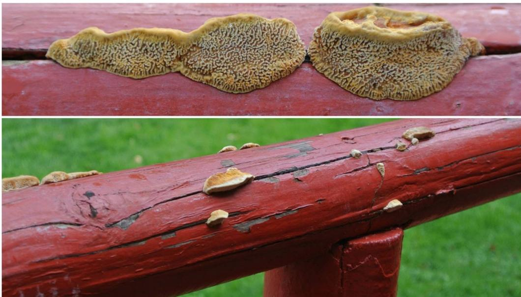
Abb. 12a: Feuchtenester, entstanden durch Risse in der Beschichtung: Die Fruchtkörper des Zaunblättlings zeigen einen verdeckten Fäuleschaden an.
