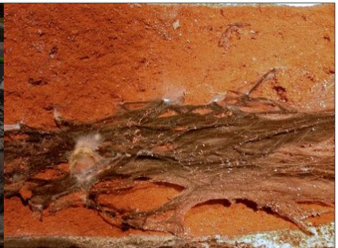
Abb. 12: Ziegelstein-Aufbruch: Der Stein ist durch Alter und Feuchteschäden aufgrund von aufsteigender Feuchte gezeichnet, in den Rissen wächst der Braune Kellerschwamm (*Coniophora puteana*).
