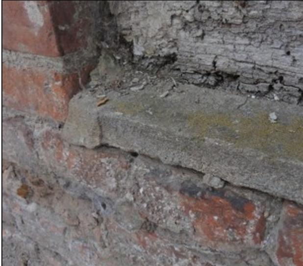
Abb. 13: Typisches Schadensbild nach langem Leerstand eines Fachwerkhauses: Moderfäulepilze haben sich an der Schwelle angesiedelt; noch wäre eine Reparatur möglich. Ein Insekten-schaden liegt noch nicht vor.
