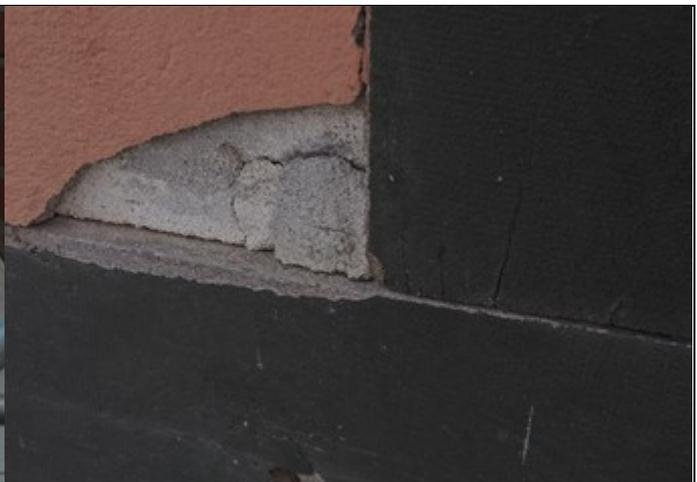
Abb. 6. Ist der Putz zu hart und fehlt der Kantenschnitt, platzt der Putz nach kurzer Zeit ab und mehr Wasser dringt ein.
