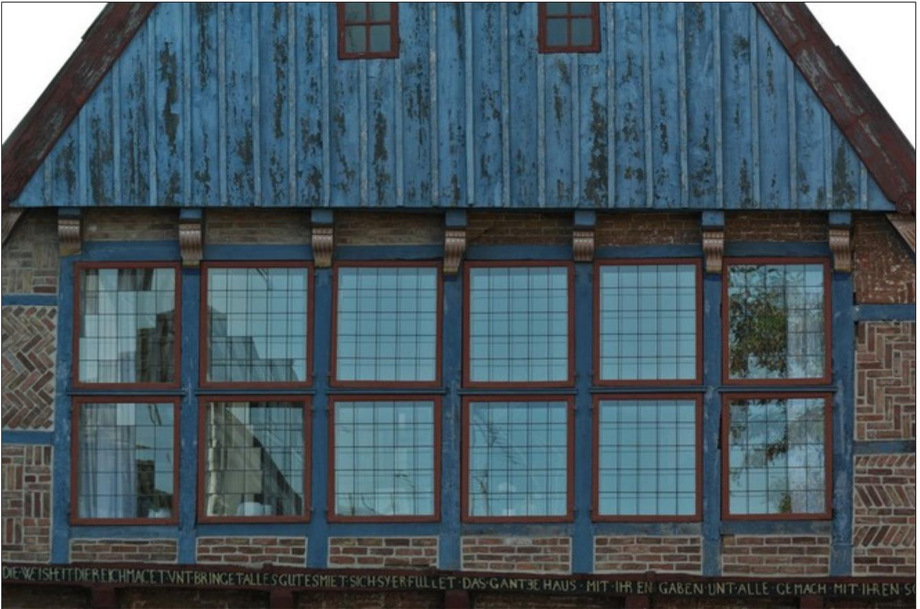
Abb. 2: Große Fensteranlage in einem Fachwerk an der Elbemündung in Otterndorf mit einem für die Region typischen Gefach-Material: gebrannte Ziegeln in einem vergleichsweise weichen Mörtel.
