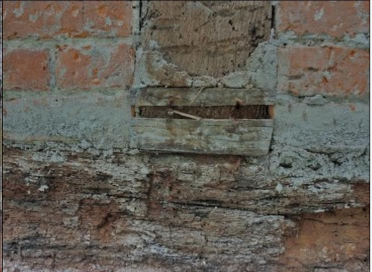
Abb. 14. Fachwerk-„Schutz“ mit einer Putzfassade (für die Sanierung abgeschlossen): Durch die verminderte Abtrocknungsfähigkeit des Holzes unter dem Putz kam es zu einer außen gelegenen Fäule – hier ein Doppelbefall mit Braunfäule durch einen Kellerschwamm (*Coniophora* sp.) und Moderfäulepilzen, zudem ein Insekten-schaden durch den Buntten Nagekäfer (*Xestobium rufovillosum*).
