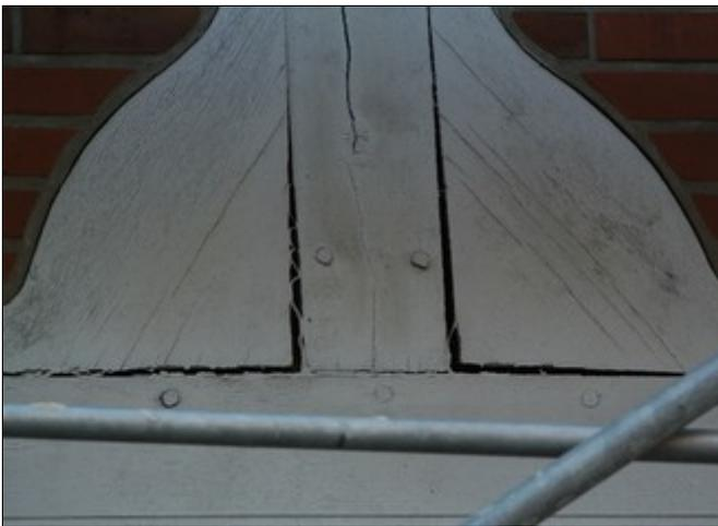
Abb. 5. Holz schwindet, quillt und verzieht sich; kein Silikon der Welt kann die Risse ohne Abriss dauerhaft überspannen.
