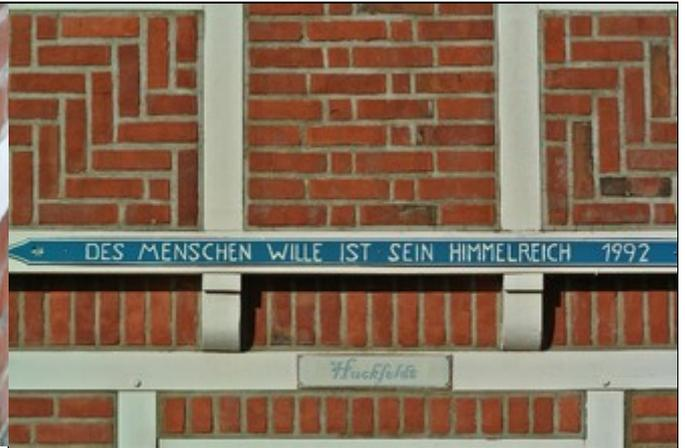
Abb. 4. Giebelseite von Abb. 3: Modernes Fachwerk, aber die Schwellen faulen schon – der Teufel steckt im Detail. Verbaut wurde weitringiges Nadelholz, das leicht vom Kellerschwamm zerstört wird; Fachkenntnisse wären hilfreich gewesen.
