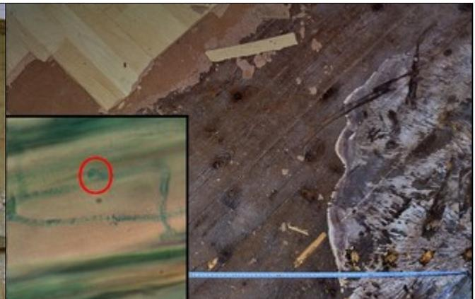
Abb. 10: Typisches Schadensbild mit Echem Hausschwamm (*Serpula lacrymans*) nach einem Wasserschaden zwischen altem Dielenboden und einer neue Laminat-Auflage mit Ausgleichslage aus Holzfaserverplatten: Wasser wird gefangen und die Mycelien breiten sich oft unbemerkt aus; Eckbild: Hyphen mit Schnalle im Holz vor der Zuwachszone (Kreis).
