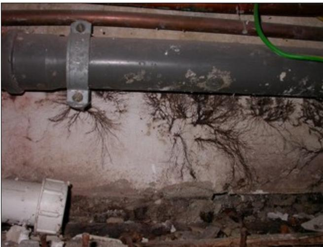
Abb. 11: Duschwannen-Unterkonstruktion. Kachelwände und Duschwanne verhindern, dass eintropfendes Wasser entweichen kann: Mycelwachstum und in der Folge Braunfäule-Schäden durch einen Kellerschwamm (*Coniophora* sp.) resultieren daraus.
