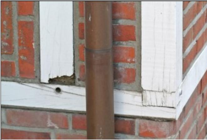
Abb. 3. Wie kurzlebig Schwellen sein können, zeigt dieses Bild eines Fachwerks von 1992, Ferienwohnung in der Innenstadt einer Kleinstadt mit hohem Fachwerkanteil. In der Innenstadt soll ein Ensemble aus Fachwerkgebäuden gezeigt werden.
