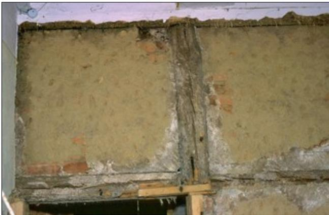
Abb. 9: Typisches Schadensbild nach langem Leerstand eines Fachwerkhouses: Echter Hausschwamm (*Serpula lacrymans*) an Innen-Fachwerk; durch Reparatur und nachhaltige Trocknung wurde der Schaden behoben; aufgrund der offenen Konstruktion wurde nur das feuchte Holz angegriffen; der Lehmputz war zu trocken.
