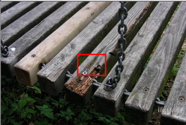
Abb. 3: Trittbalken mit Braunfäule nach einem Landregen. Probennahme vom gesunden Holz mit Übergang zum zerstörten entnehmen.
