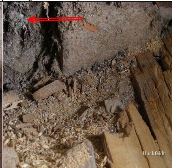
Abb. 6: Detail von Abb. 5: Ein günstiges Stücke zur Probeneinsendung (Pfeil); bitte zusammen mit etwas von dem faulen Holz schicken oder gern mehr Material.
